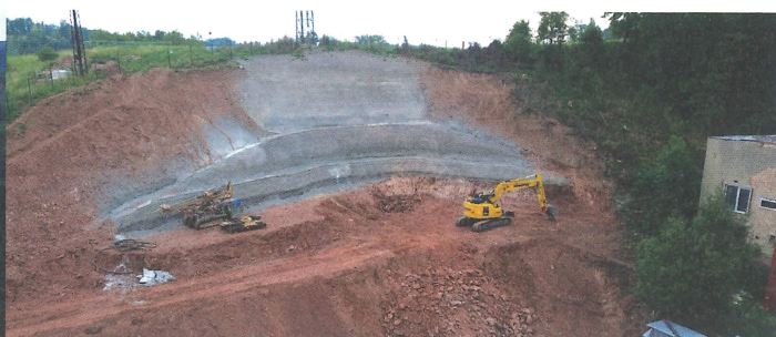
Obr. 8 Stavebná jama – portál tunela Dolní Radechová
