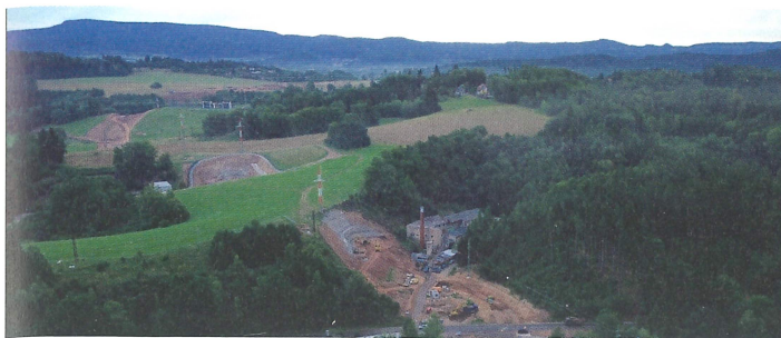
Obr. 7 Pohľad na trasu tunela Dolní Radechová
