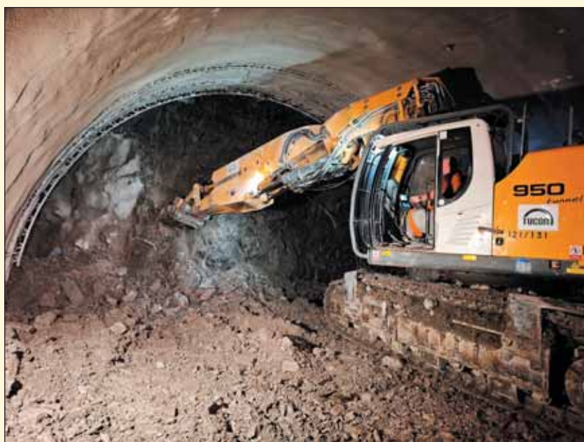
Obr. 6 Otváranie záberu bagrom v tuneli Okruhliak
