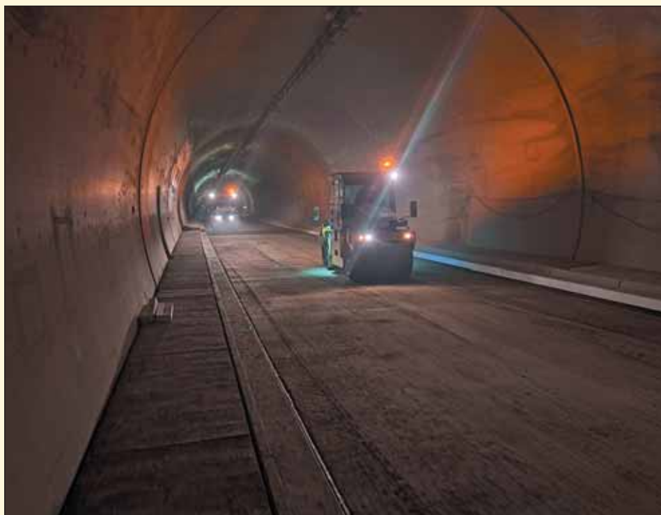
Obr. 7 Pokládka podkladnej vrstvy vozovky z CBGM v tuneli Čebrať
