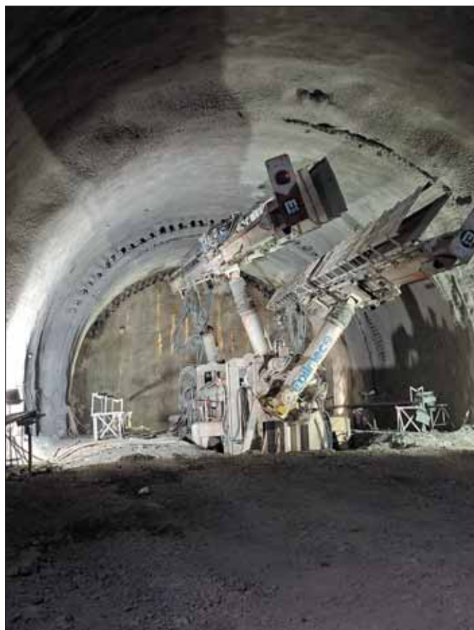
Obr. 7 Soilmec ST 120 – spevňovanie horninového prostredia Fig. 7 Soilmec ST 120 – rock mass stabilization
