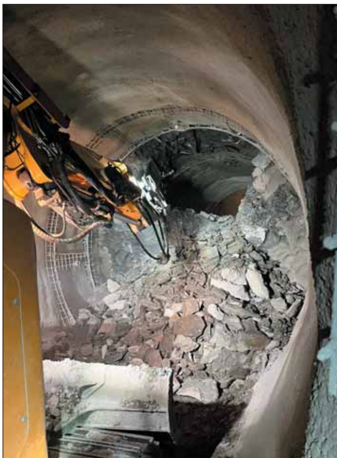
Obr. 2 Prerazenie priečného prepojenia tunelov Fig. 2 Breakthrough of the tunnel cross passage
