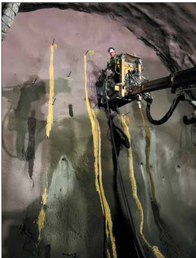
Obr. 4 Injektáž kaloty v TT5a Fig. 4 Top heading grouting in TT5a
